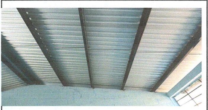
Foto 2: Sustitución de lámina por lámina troquelada
