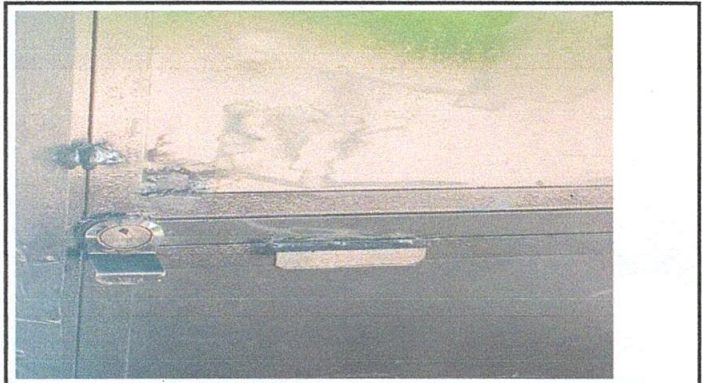
Foto 4: Sustitución de chapas de puertas de metal
